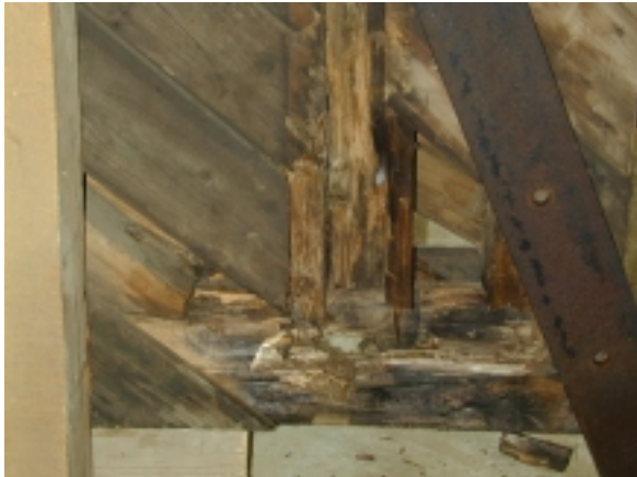
Detail: Verfaulte Holzteile
