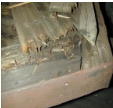
Detail: Abgefaltete und vermorschte Holzteile
