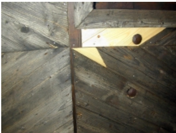
Detail: Stabilisierung und Ergänzungen von Neuteilen, Muster wenn man Farbangleichung durchführen würde
