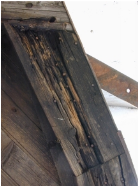
Detail: Verfaulte Holzteile mit Pilzbefall
