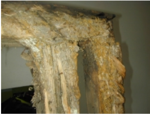
Detail: Verfaulte Holzteile mit Pilzbefall
