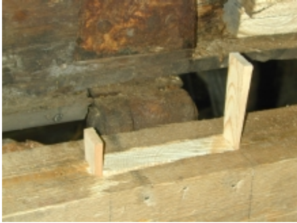
Detail: Fixierung von neuen Holzteilen
