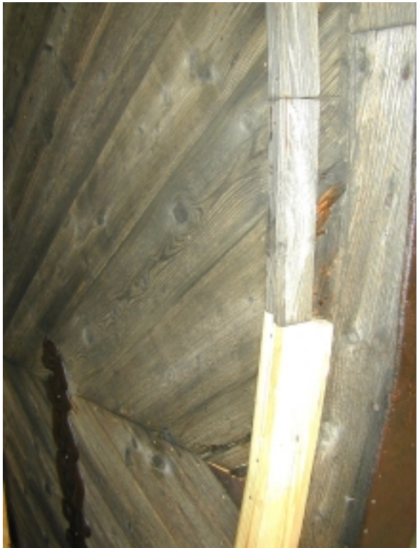
Detail: Geschlossene Flächen mit Stabilisierung und Ergänzungen von Neuteilen
