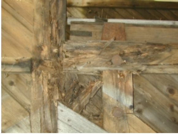
Detail: Verfaulte Holzteile
