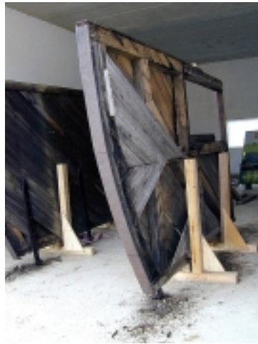
Detail: Verfaulte Holzteile mit Pilzbefall und Abnahme der Sichtverschalung
