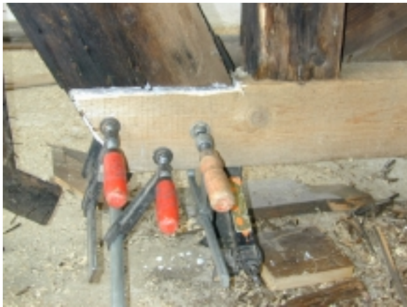
Detail: Verfaulte Holzteile wurden erneuert und zusätzlich mit Winkel stabilisiert
