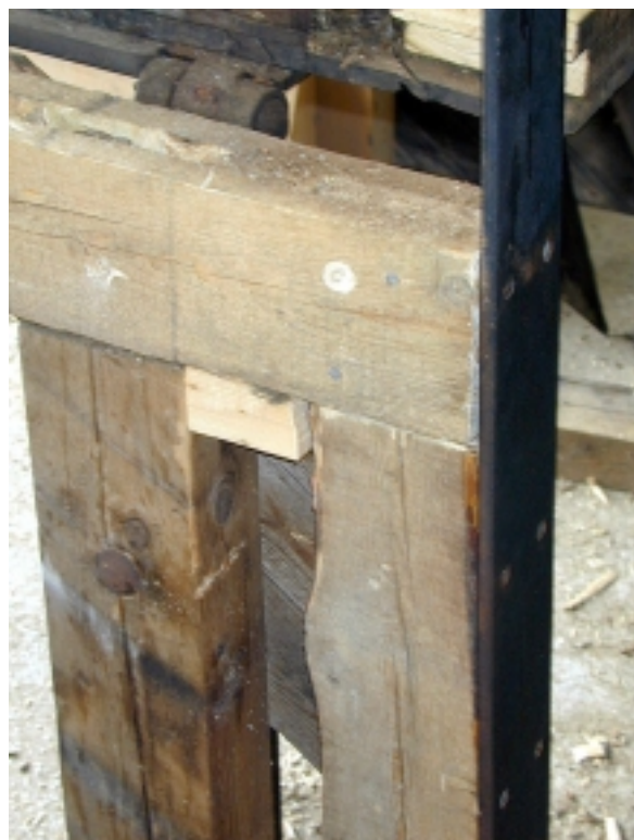
Detail: Verfaulte Holzteile wurden erneuert und zusätzlich mit Winkel stabilisiert
