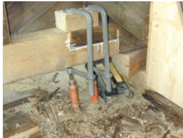
Detail: Verfaulte Holzteile wurden erneuert und zusätzlich mit Winkel stabilisiert
