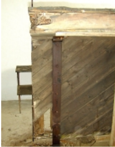
Detail: Verfaulte Holzteile
