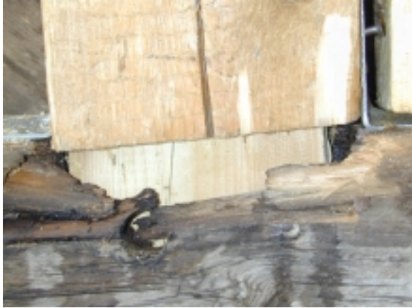
Detail: Zapfenübergänge bei Erneuerungsarbeiten
