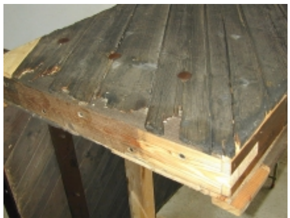
Detail: Stabilisierung und Ergänzungen von Neuteilen, Muster wenn man Farbangleichung durchführen würde
