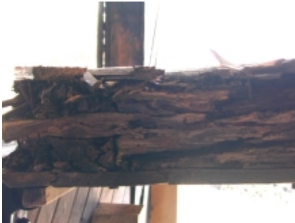
Detail: Verfaulte Holzteile
