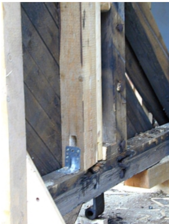
Detail: Verfaulte Holzteile wurden erneuert und zusätzlich mit Winkel stabilisiert
