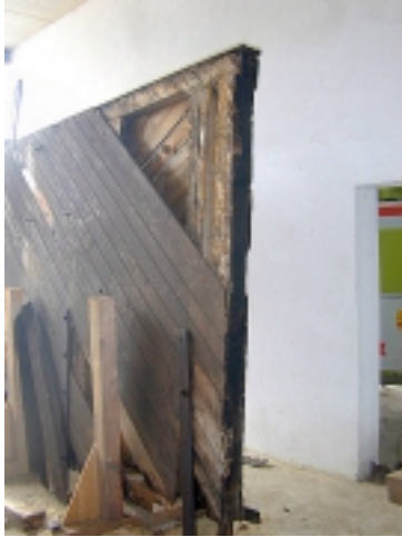
Detail: Verfaulte Holzteile mit Pilzbefall und Abnahme der Sichtverschalung
