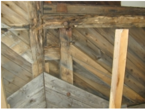
Detail: Verfaulte Holzteile mit Pilzbefall
