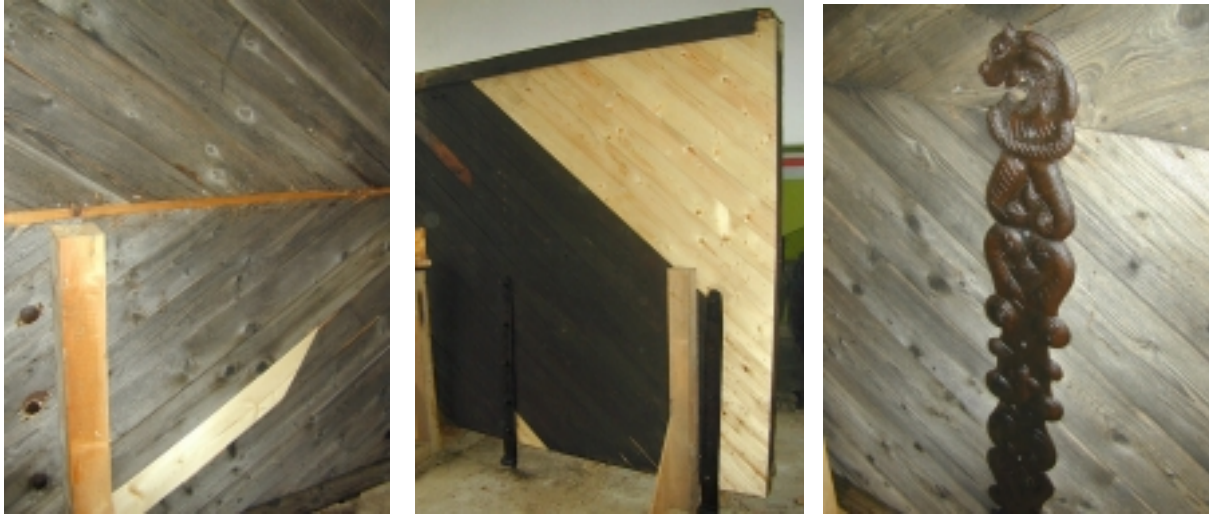
Detail: Stabilisierung und Ergänzungen von Neuteilen mit Oberflächenbehandlung
