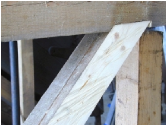
Detail: Holzergänzung, Holzfixierung und Neuherstellung
