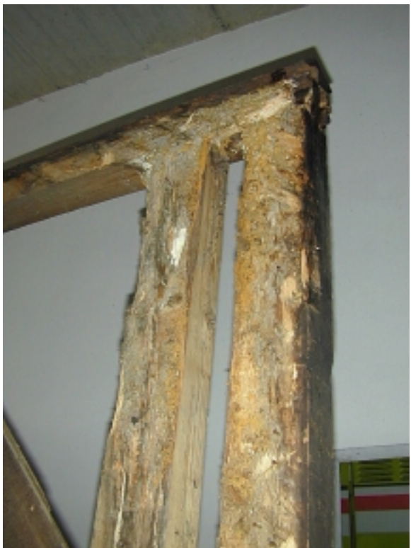
Detail: Verfaulte Holzteile mit Pilzbefall
