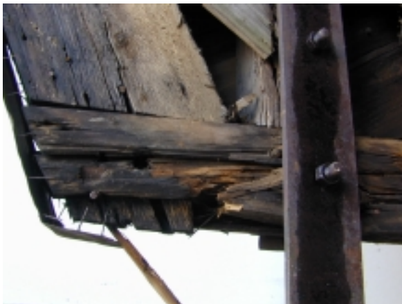
Detail: Verfaulte Holzteile
