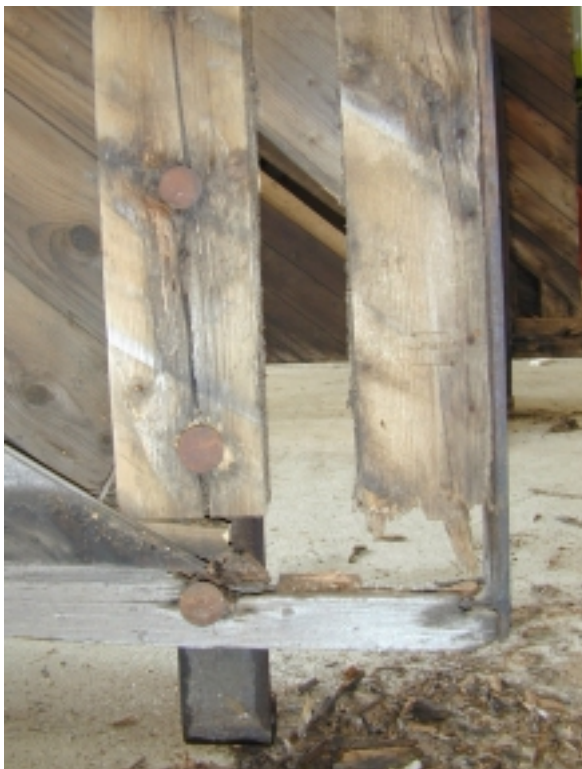
Detail: Verfaulte Holzteile
