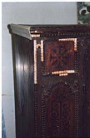
Detail von erneuerten Gesimse, Kugelleisten, Pyramidenknöpfe, Zierleiste und Sockelteil
