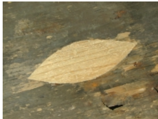
Detail: Holzausbesserungsarbeiten und Holzergänzungsarbeiten
