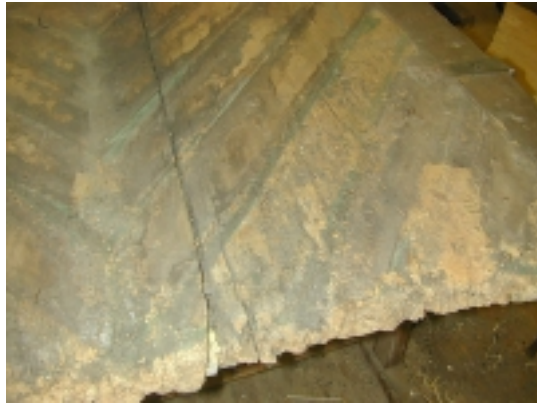
Detail: Holzschäden, abgefaulte Holzteile und Längsrisse
