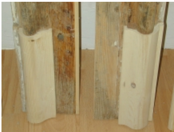
Detail: Holzausebesserungsarbeiten mit Kittungsarbeiten
