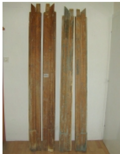
Detail: Holzausebesserungsarbeiten mit Kittungsarbeiten
