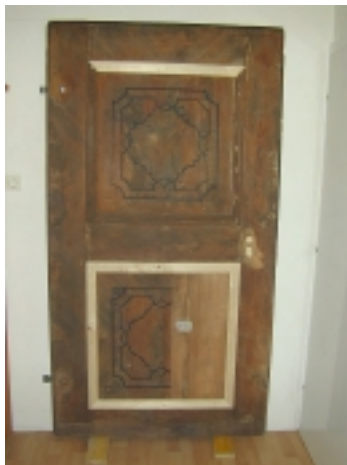
Detail: Holzausbesserungsarbeiten und Holzergänzungsarbeiten
