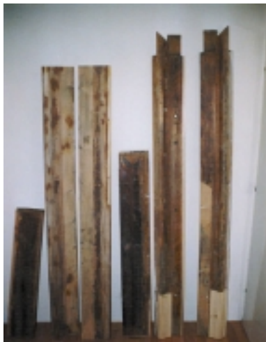
Detail: Holzausebesserungsarbeiten mit Kittungsarbeiten
