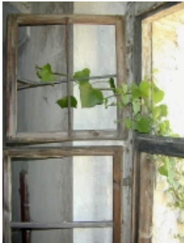
Detail: Abgefaulte Holzteile, gebrochene Glas.- und Holzverbindungen mit Oberflächenschäden
