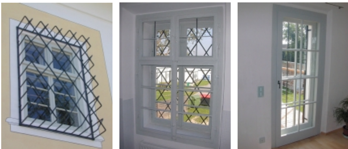
Detail: OG – F13, F14 und Balkontüre
