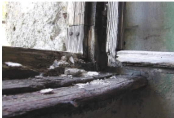
Detail: Abgefauten Holzteile, gebrochene Glas.- und Holzverbindungen mit Oberflächenschäden
