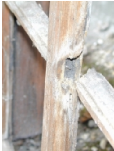
Detail: Abgefaulte Holzteile, gebrochene Glas.- und Holzverbindungen mit Oberflächenschäden
