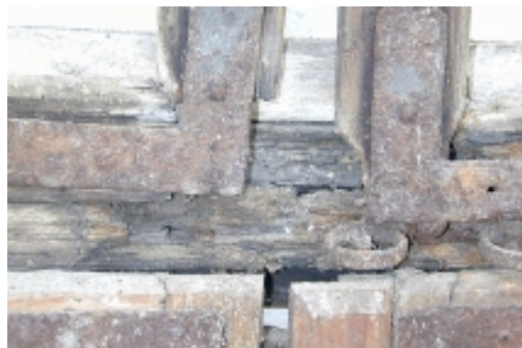
Detail: Abgefauten Holzteile, gebrochene Glas.- und Holzverbindungen mit Oberflächenschäden
