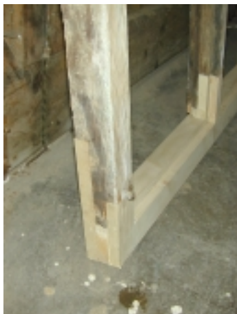
Detail: Holzverbesserungsarbeiten
