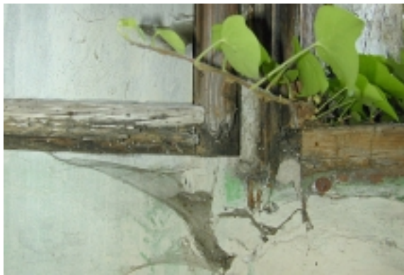
Detail: Abgefauten Holzteile, gebrochene Glas.- und Holzverbindungen mit Oberflächenschäden
