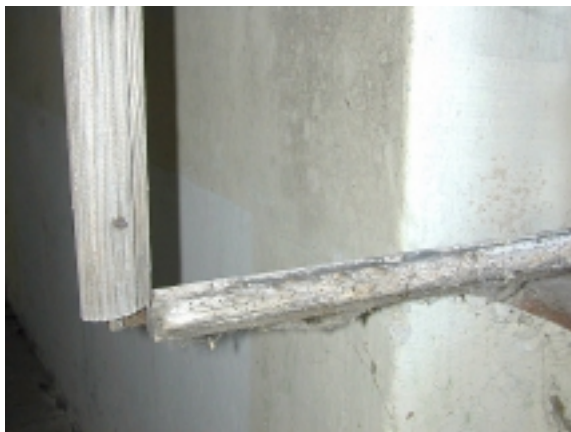
Detail: Abgefaulte Holzteile,
