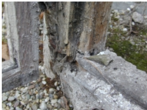
Detail: Abgefaulte Holzteile, gebrochene Glas.- und Holzverbindungen mit Oberflächenschäden
