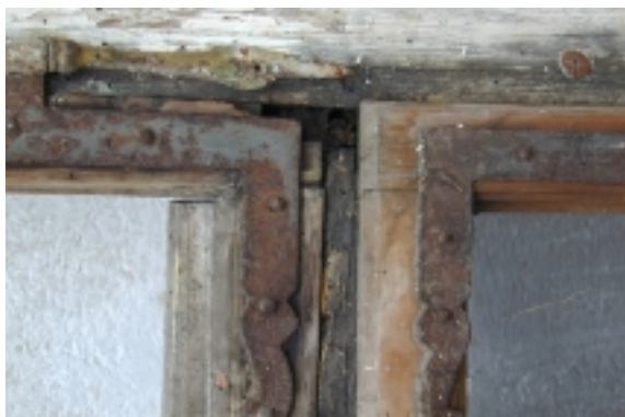
Detail: Abgefauten Holzteile, gebrochene Glas.- und Holzverbindungen mit Oberflächenschäden
