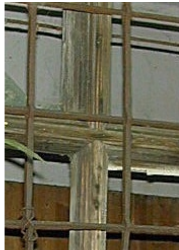
Detail: Abgefaulte Holzteile, gebrochene Glas.- und Holzverbindungen mit Oberflächenschäden
